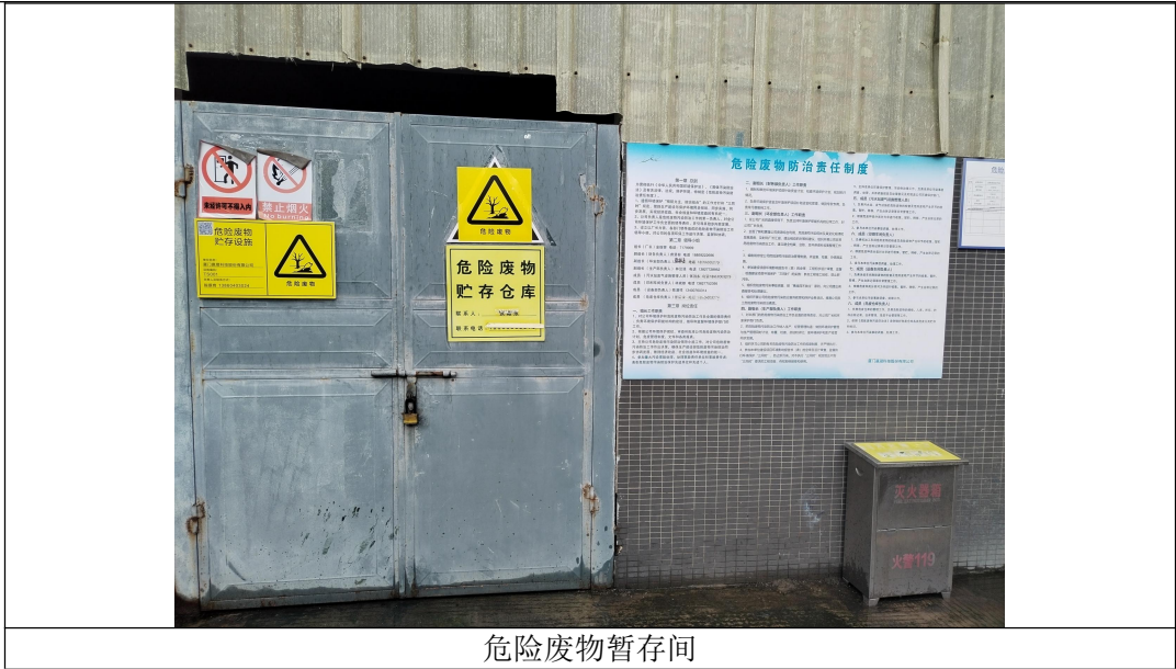
图 3.1-6 项目危险废物暂存间现状图
